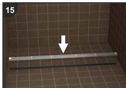
15 Togliere la protezione in polistirolo e poi inserire la griglia Remove the polystyrene protection and then put the grid
