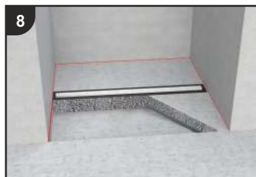
8 Riempimento con materiale cementizio con formazione del piano di pendenza, otturare il canale con l'apposita protezione in polistirolo in dotazione. Filled with cement material till previously marked slope line, place supplied protective polystyrene into channel to protect it from filling with cement.
