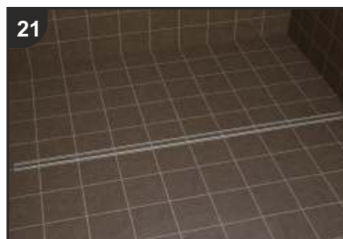
21 Griglia Double Face montata con la mattonella incollata all'interno della griglia. Lo scarico è quasi INVISIBILE. Double Face grid mounted with the tile glued to the inside of the grid. The drain is almost INVISIBLE.
