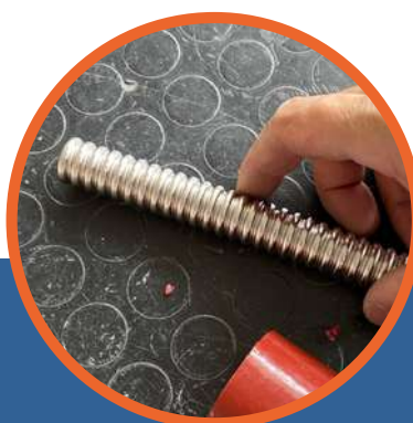
Togli l'isolamento Remove the insulation
