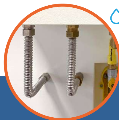
Utilizza il tubo per i tuoi collegamenti: è conforme al trasporto di acqua potabile. Use the tube for your connections: it is compliant with the transportation of sanitary water.
