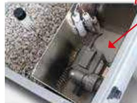
Una centralina elettronica comanda il funzionamento della pompa attraverso delle sonde.
